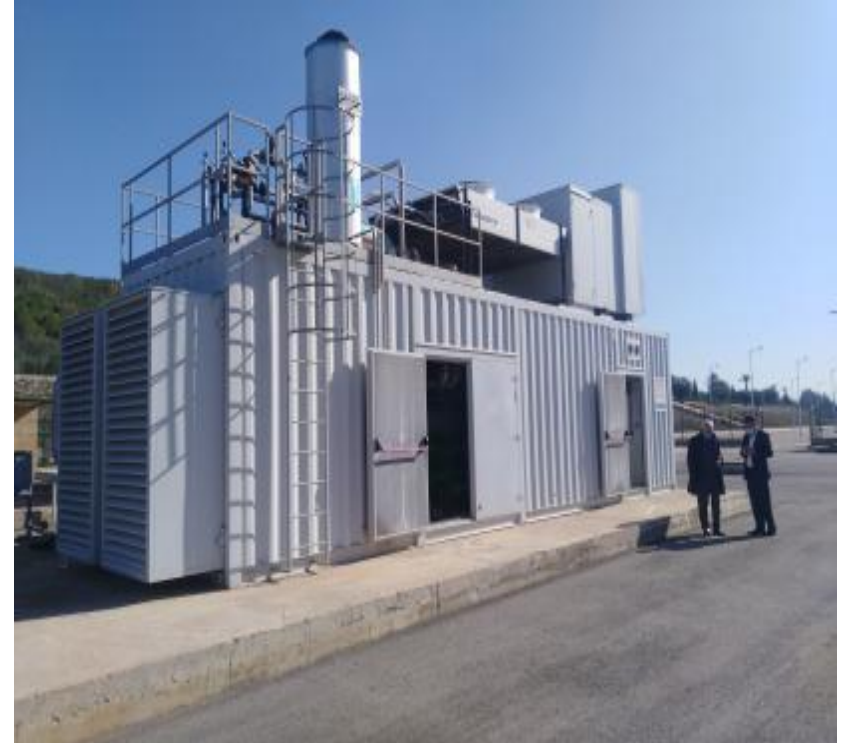
Unité de cogénération, unité de pompage de gaz et torchère à la Décharge d'OUED SMAR, Algérie
